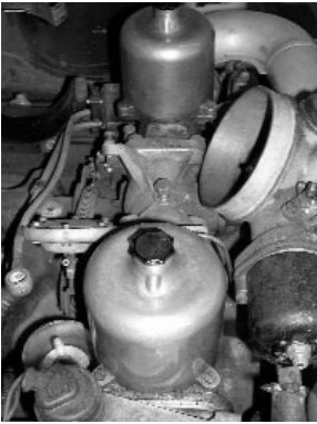
Figuur 12. Alle aansluitingen zijn gedemonteerd.
